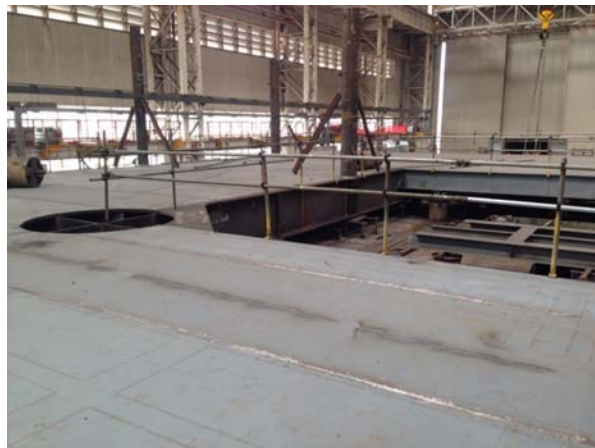
渤中28-2S WHPB--2#片铺板
