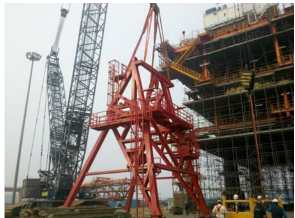
惠州钻机模块DES的井架基座
