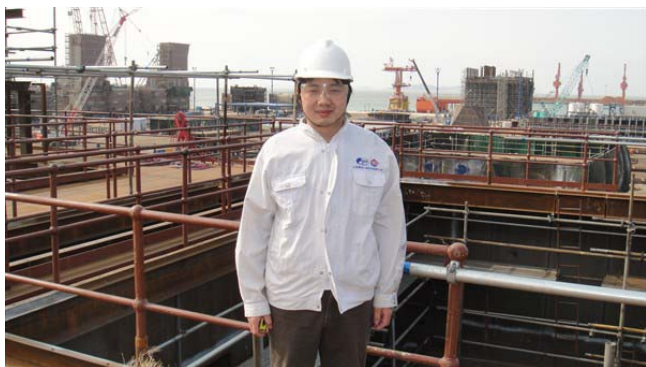
海水淡化PT模块结构顶部
