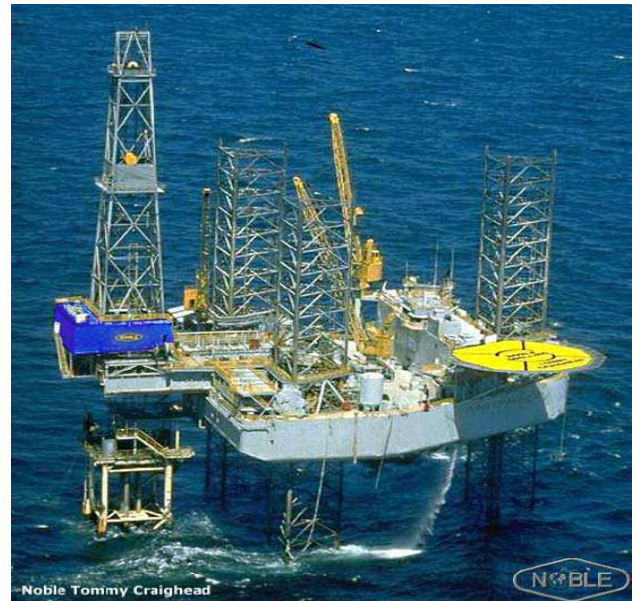
图1 自升式钻井平台
