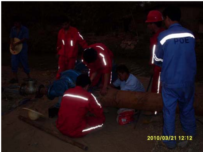
连接上水管线
