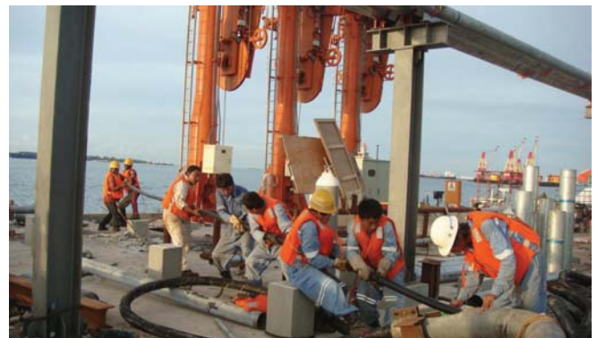
加油好男儿！ Cable Anchoring
