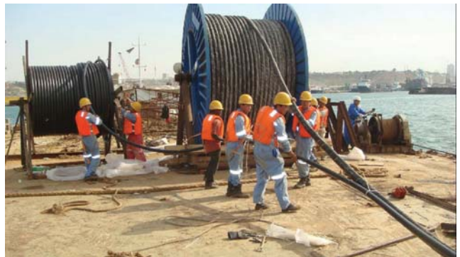
电缆和HDPE水管安装
