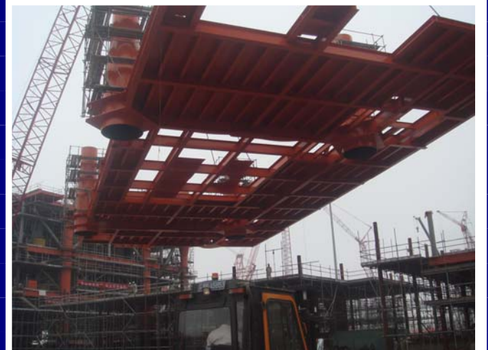
SZ36-1WHPK组块23.5米吊装
