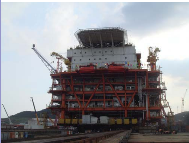
SZ36-1 顺利完工
