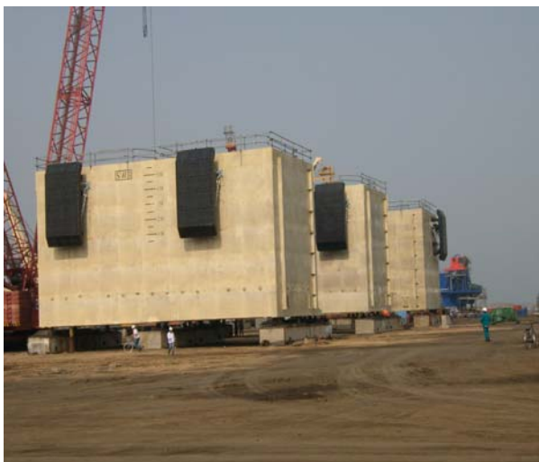
海水淡化 CAISSON场地建造完成
