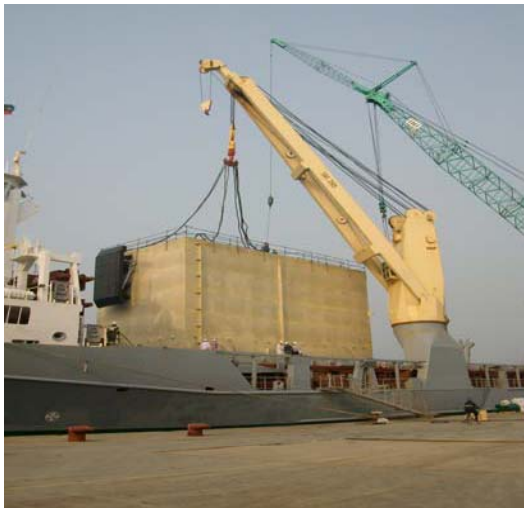
海水淡化 CAISSON装船
