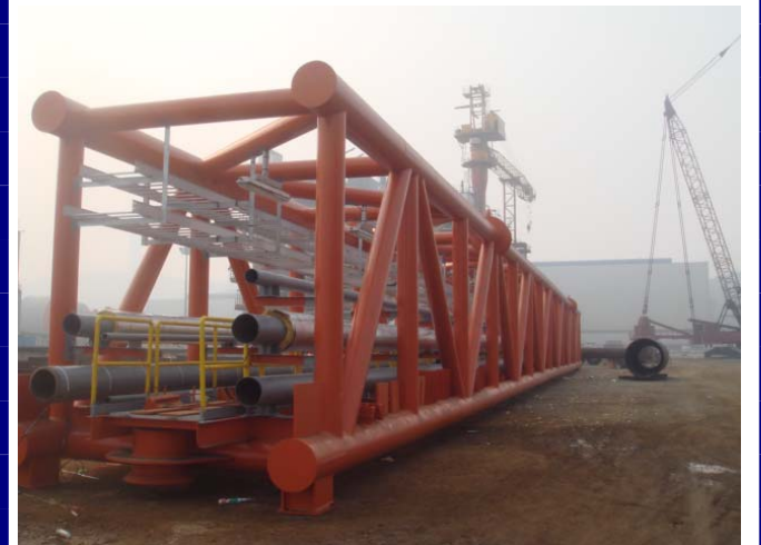
SZ36-1WHPK组块栈桥
