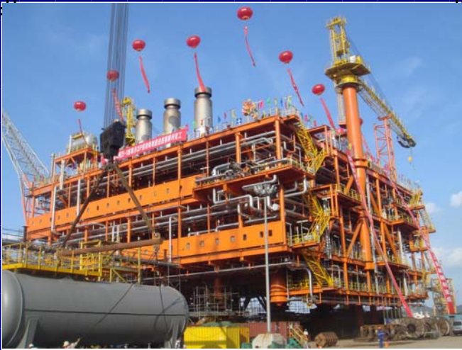
JZ25-1S 圆满竣工
