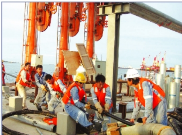
海底电缆海上铺设现场 Laying submarine cable
