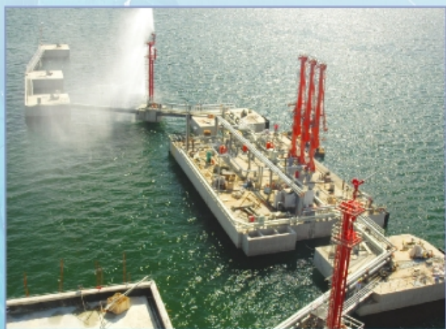
平台消防系统试验 Testing fire system of platform
