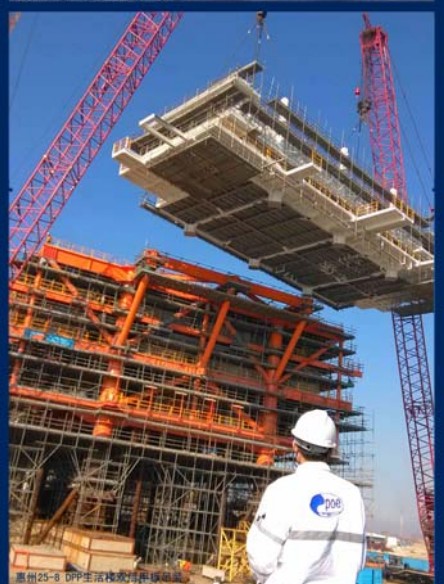
惠州25-8 DPP生活楼提升过程
